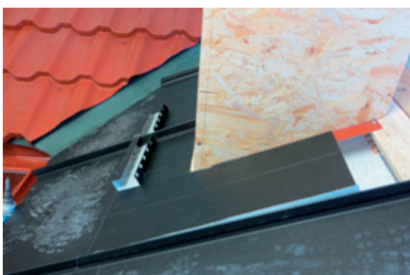
Obr. c – po odstrihnutí vonkajšej hrany zámkov prvej šablóny krytiny Classic v mieste priečného preloženia s druhou šablónou, sa šablóna uchyť nerezovými skrutkami a osadia sa vetracie profily.
